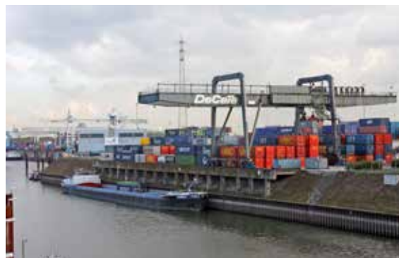
Container-Terminal am Duisburger Hafen (Quelle: SGKV)
