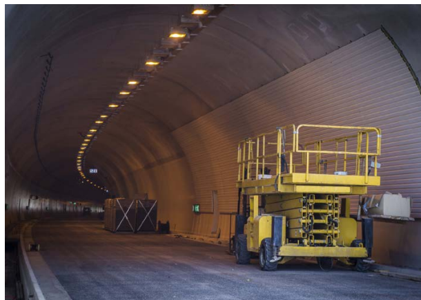
Arbeiten in einem Tunnel. (Quelle: © dejank1/Fotolia.com)
