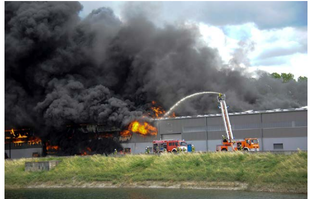
Die erarbeiteten Brandschutzvorgaben werden dazu beitragen, den Brandschutz von Lagerhallen mit Hochvoltspeichern zu verbessern.
