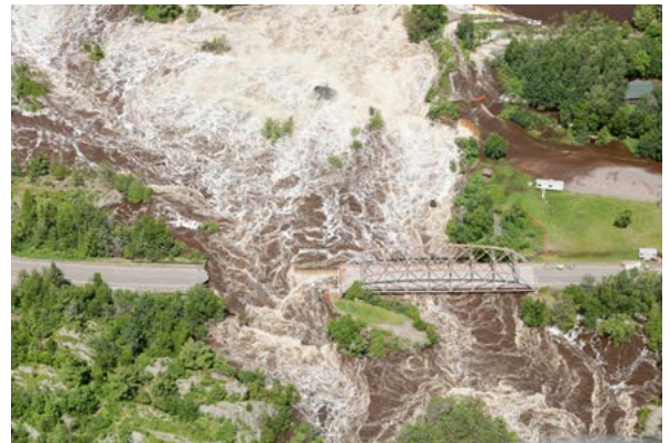
Durch Hochwasser können Straßen unpassierbar werden. (Quelle: © iStock.com/BanksPhotos)
