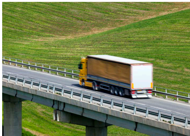
Straßenbrücken sind häufig großen Belastungen ausgesetzt. (Quelle: © iStock.com/Bim)
