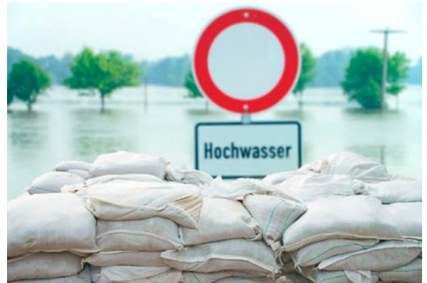
Hochwasserschutz durch einen aus Sandsäcken errichteten Deich. (Quelle: © PhotographyByMK / Fotolia.com)
