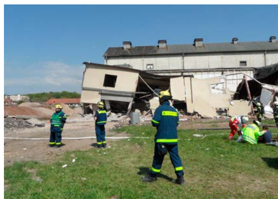
Eingestürztes Gebäude (Quelle: VDI Technologiezentrum GmbH/Wey)
