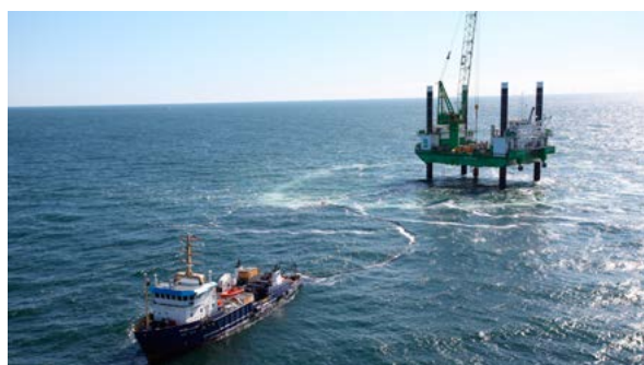
Vorbereitung zum Bau eines Offshore-Windparks (Quelle: von Mandelsloh/Deutsche Offshore Consult GmbH)
