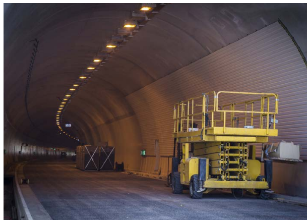
Arbeiten in einem Tunnel. (Quelle: © dejank1/Fotolia.com)
