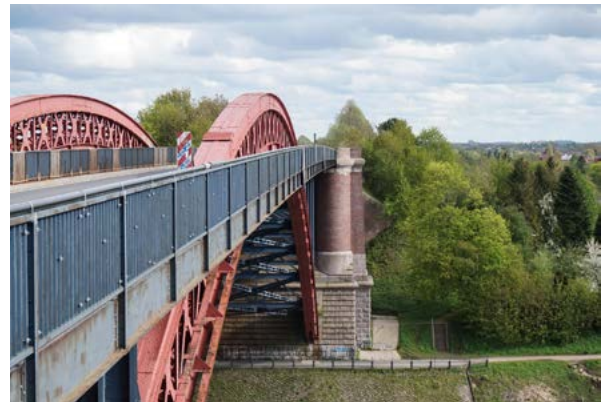
Alternde Brückenbauwerke können bei notwendigen Sperrungen zu erheblichen Verkehrsstörungen führen.
