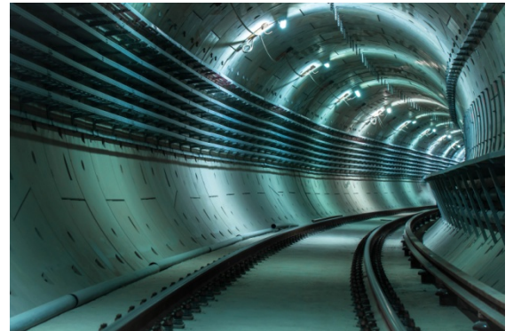
Verkehrsinfrastrukturen wie Eisenbahntunnel müssen besonders geschützt werden. (Quelle: © Fotolia.com – svedoliver)
