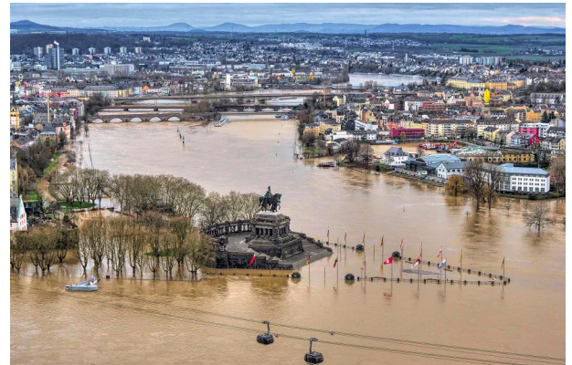
Übersichtsaufnahmen eines Hochwassergebietes helfen den Einsatzkräften bei der Lageeinschätzung.
