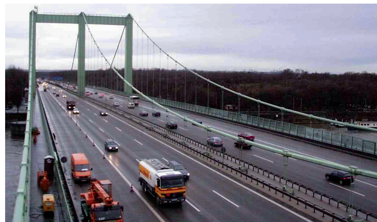
Brücken sind besonders wichtige Verkehrsinfrastrukturen mit einer hohen Bedeutung für das Straßennetz (Quelle: BASt)
