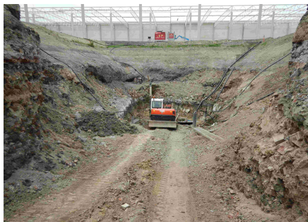
Aufwendige Bergung eines Bombenblindgängers auf einem Industriegelände im Ruhrgebiet (Quelle: P-H-Röhl NRW GmbH).
