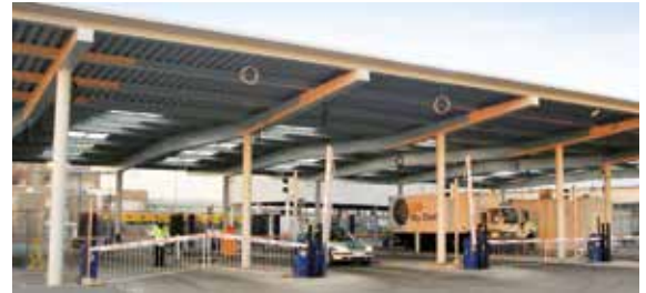
Vorfeldkontrollstelle am Flughafen (Quelle: Fraport AG)
