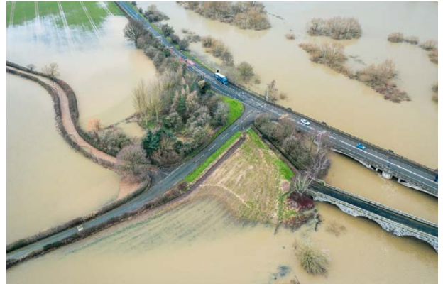
Naturkatastrophen oder Unfälle können Straßenbauwerke massiv beschädigen. Vor einer erneuten Freigabe für den Verkehr sind aufwändige Untersuchungen notwendig.
